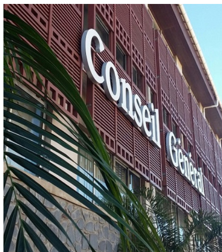
Le bâtiment du Conseil départemental
